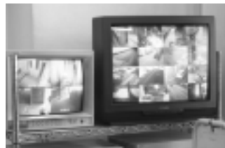
管理事務所内にある防犯カメラ用のモニター。右のモニターには16分割型。動く人や物に反応して自動的に録画されるシステム
