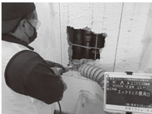
エントランス配管スペース破砕作業
