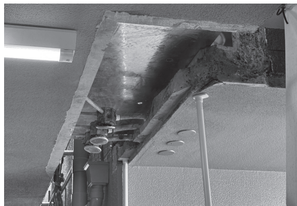
エクスパンションジョイントの隙間拡幅工事の現場
